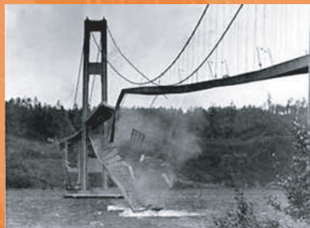
Im US Bundesstaat Washington geriet bei einem lang anhaltenden Sturm am 07.11.1940 die Tacoma-Hängebrücke so stark in Schwingung, dass sie schließlich einstürzte.
